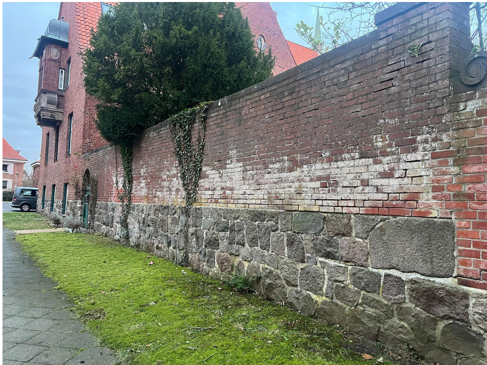
Abb. 1: Lübeck, Bonnusstraße, Mauer aus Bruch- und Backsteinen (Foto: H. AL DAQQAQ, alle weiteren Fotos: H. MENZEL-HARLOFF).
