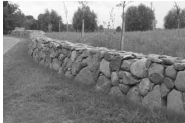
Abb. 4: Neu errichtete Feldsteinmauer in Rühn (Lkrs. Güstrow), im Hintergrund Kopfweiden. Foto: H. MENZEL-HARLOFF
